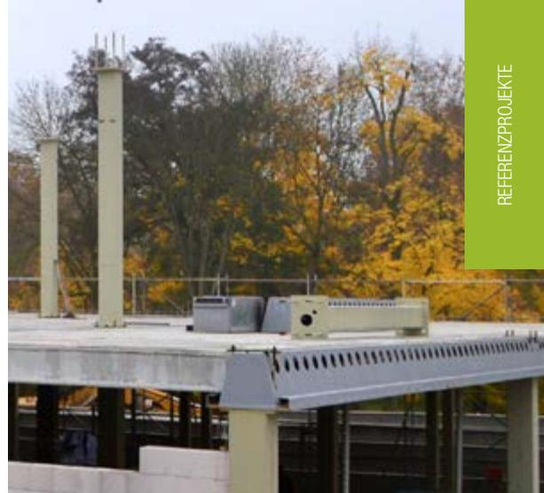
Mit Peikko Deltabeam wird ein Versatz zwischen Deckenebenen mit Spannbeton-Hohlblechen und Elementdecken realisiert. Die Verbundträger sind größtenteils in die Decke integriert. Die Verbundstützen des Obergeschosses werden an den Peikko Ankerbolzen der Verbundstützen im Erdgeschoss befestigt.
