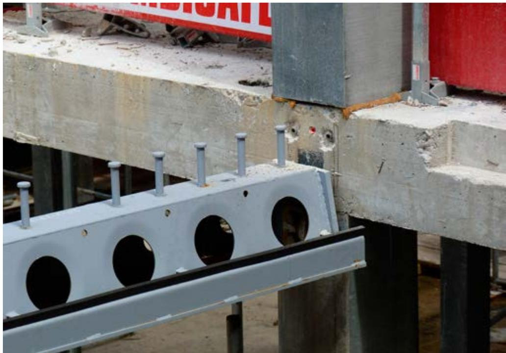
Deltabeam Verbundträger werden mit PCs Konsolen an aufgehende Betonbauteile angeschlossen. PCs Konsolen ermöglichen eine durchgehende, glatte Schalung.
