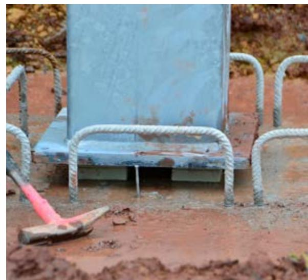
Peikko Verbundstützen werden als Halbfertigteil-Elemente mit den erforderlichen Anschlüssen geliefert und können abstützungsfrei montiert und ausgerichtet werden.
