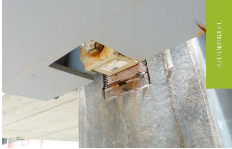
PCs Konsolen ermöglichen die einfache und schnelle Montage der Deltabeam Verbundträger oder Fertigteil-Unterzüge an aufgehende Stahlbeton-Bauteile.
