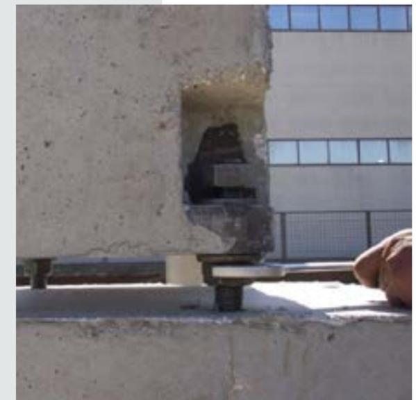
Bilder: Montage der Peikko Stützenverbindung aus Stützenschuhen und Ankerbolzen
