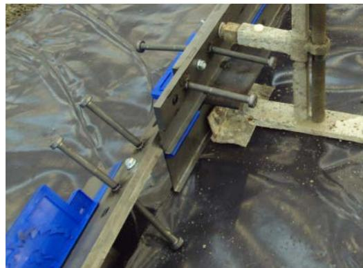
2. 根据放线的位置,把地坪缝产品放置在正确的位置上并且调整其高度.可以在连接件两端用激光水准仪或同类设备来测量核实,将水平尺横放在连接件顶部来调节使其安装垂直。
