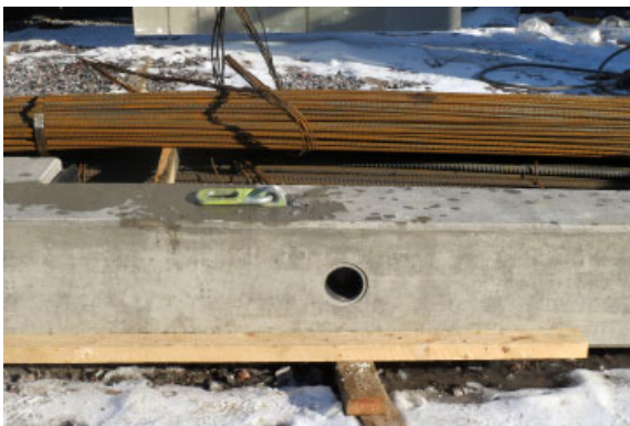
Figur 7. Hul til løftedorn i betonelementet.
