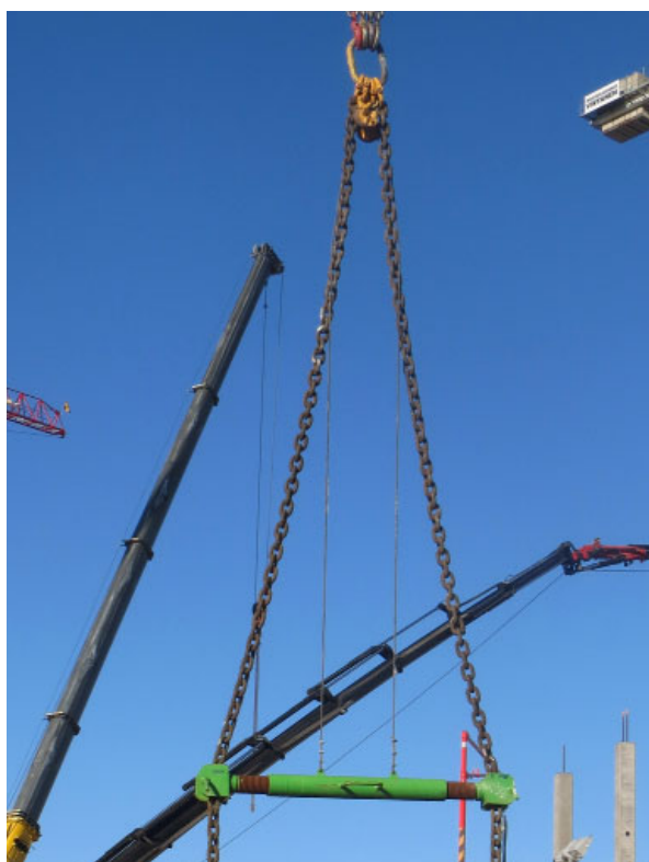
Figur 15. Fastgørelse af afstivningsåget til ringen med stålwire.
