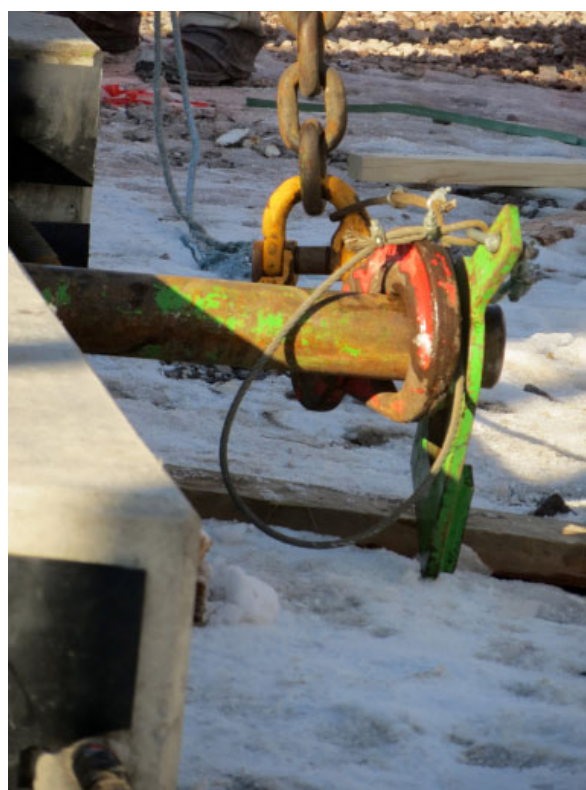
Figur 14. Fastgørelse af afstivningsåget til stropperne med stålwire.
