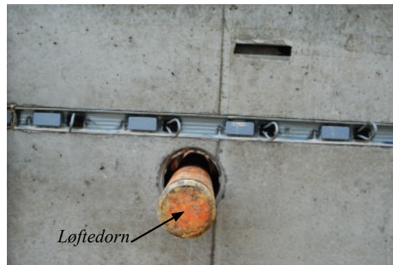
Figur 8. Løftedorn placeres i hullet.
