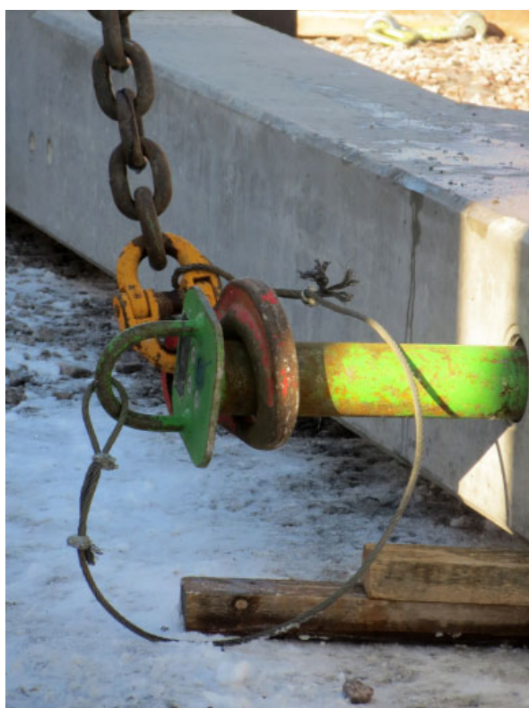
Figur 13. Fastgørelse af løftedornen til stropperne med stålwire.
