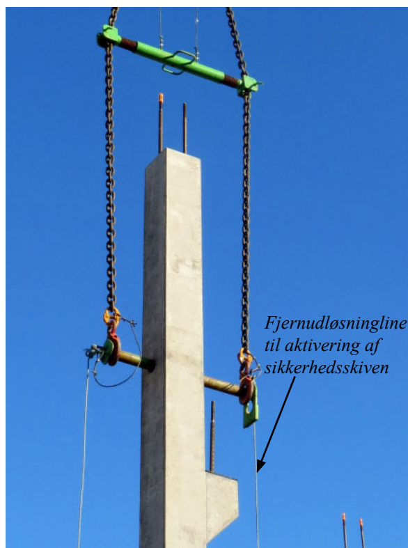
Figur 16. Samlet system, sikkerhedsskive kæder til afmontering af sikkerhedsskive og løftedorn.
