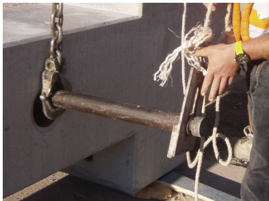
Figur 22. Stropper fastgjort med kroge.
