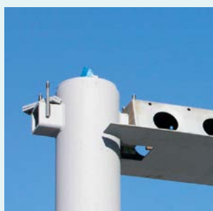
Łączenie na wspornikach słupów stalowych
