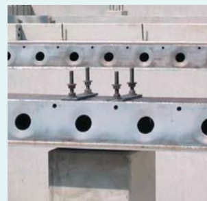
Śruby kotwiące do łączenia belki DELTABEAM® na głowicy słupa
