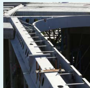
Zintegrowany szalunek do kształtowania krawędzi stropu
