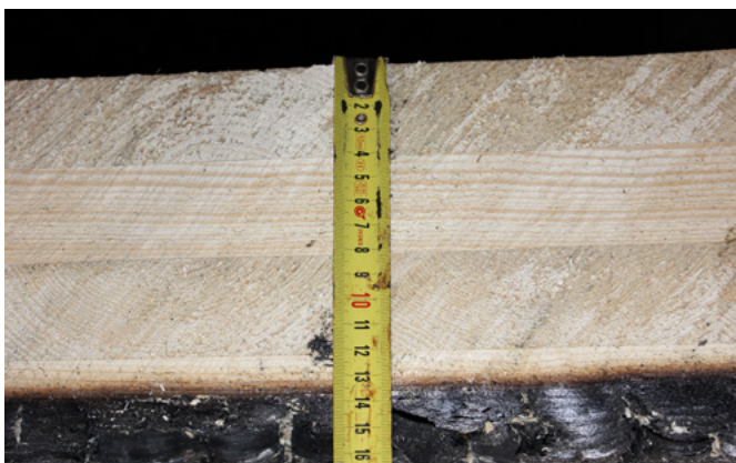
Abbildung 10. Verkohlung in der Mitte der CLT-Spannweite.
