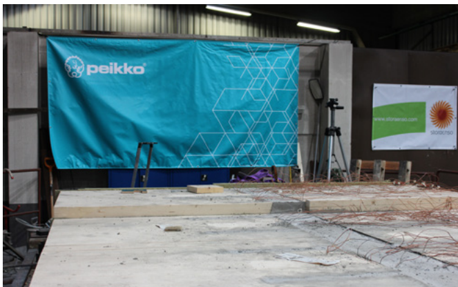
Abbildung 4. Prüfkörper für den zweistündigen Verkohlungsversuch ohne Belastung. Die CLT 200 L5s- und CLT 280 L7s-Holzelemente wurden auf den auskragenden Auflager- oder Untergurtflanschen des DELTABEAM® Verbundträgers aufgelagert. DELTABEAM® und die CLT 200 L5s-Elemente hatten die gleiche Tiefe.
