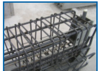
Figura 4. Ejemplos de colocación de los pies de viga PC y del tubo para el llenado de la junta en la armadura de las vigas.
