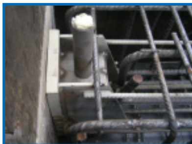
Figura 4. Ejemplos de colocación de los pies de viga PC y del tubo para el llenado de la junta en la armadura de las vigas.
