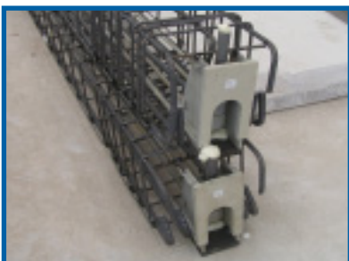
Figura 4. Ejemplos de colocación de los pies de viga PC y del tubo para el llenado de la junta en la armadura de las vigas.
