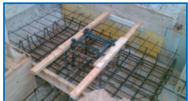
Figura 9. Ejemplo de colocación en obra de la plantilla.
