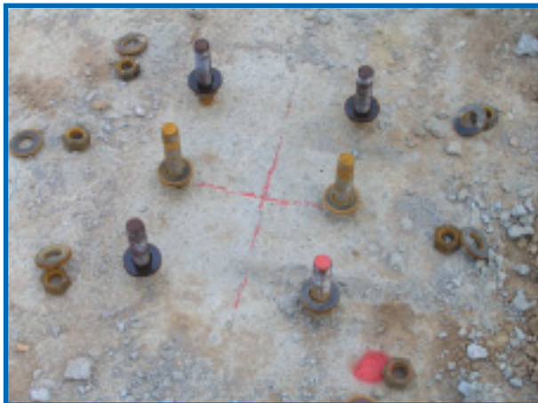
Figura 12. Detalle montaje del pilar y apriete de conexiones
