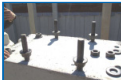
Figura 14. Detalle de montaje de un pilar prefabricado mediante tornillos de anclaje y pies de pilar de Peikko.
