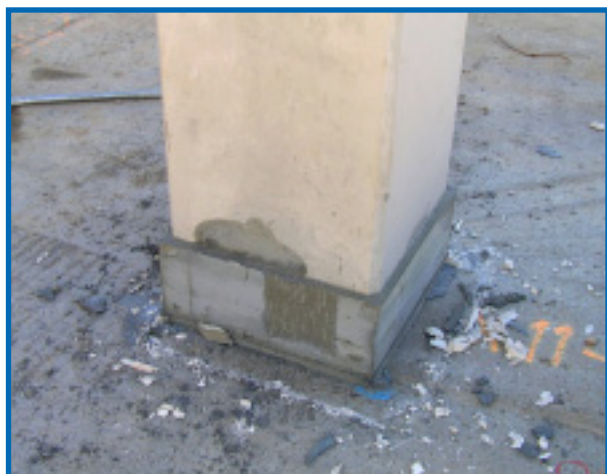
Figura13. Correcto llenado de la junta con mortero Grout
