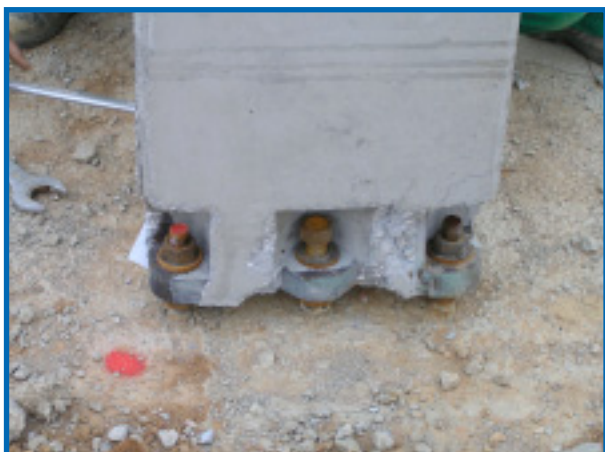
Figura 12. Detalle montaje del pilar y apriete de conexiones
