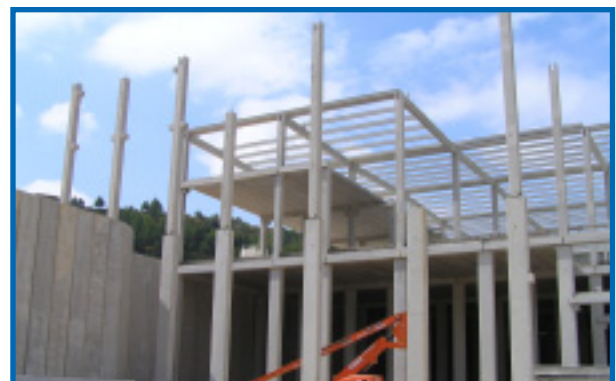
Figura 3. Empalme de pilares mediante conexiones Peikko
