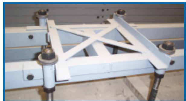
Figura 9. Ejemplo de colocación en obra de la plantilla.
