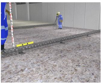
Una vez instalados los pies, asegúrese de fijar bien la altura con los tornillos y los orificios que tiene para ello la guía de enrasado.
