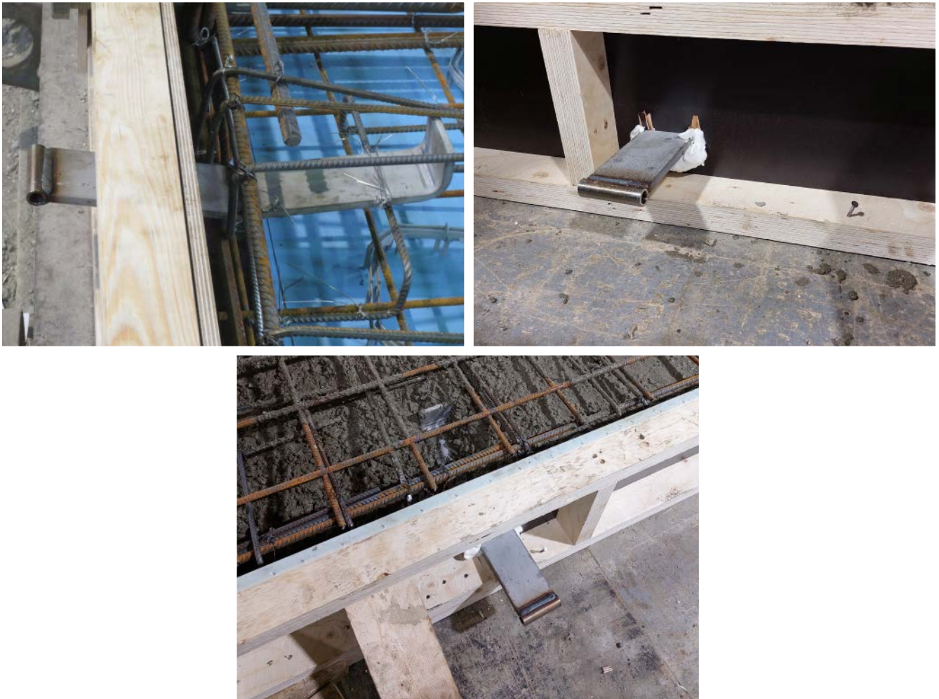
Kuva 12. PS-parvekesaranan Osan B asennus puumuottiin.
