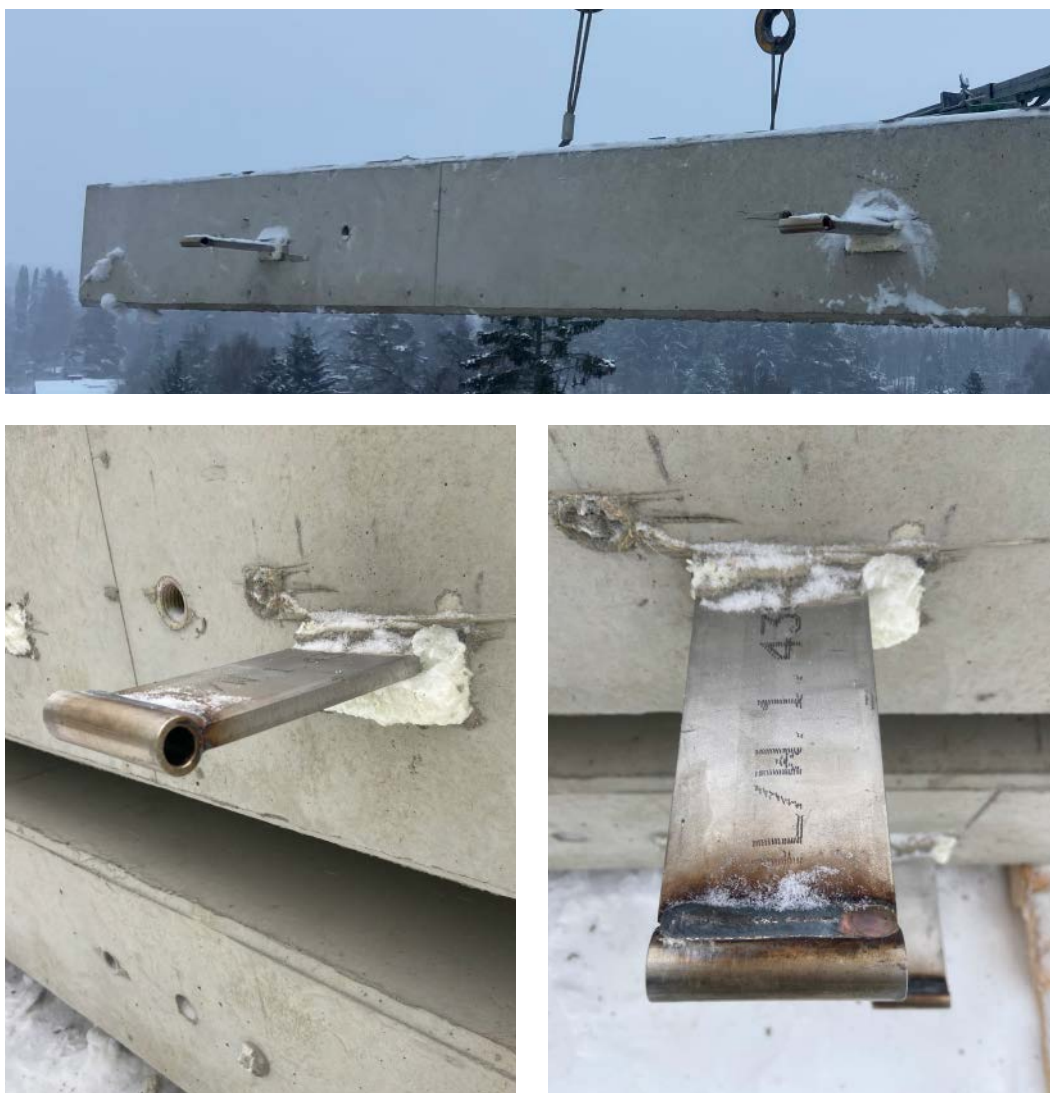
Kuva 16. Parvekelaatta, jossa PS-parvekesaranan Osat B.
