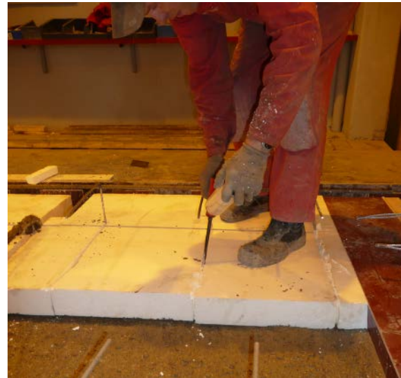
Kuva 22. Kovien eristelevyjen välisten rakojen tiivistäminen.
