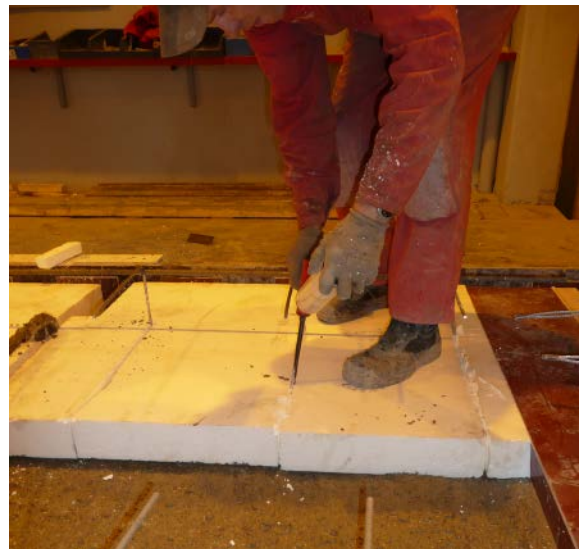
Kuva 22. Kovien eristelevyjen välisten rakojen tiivistäminen.
