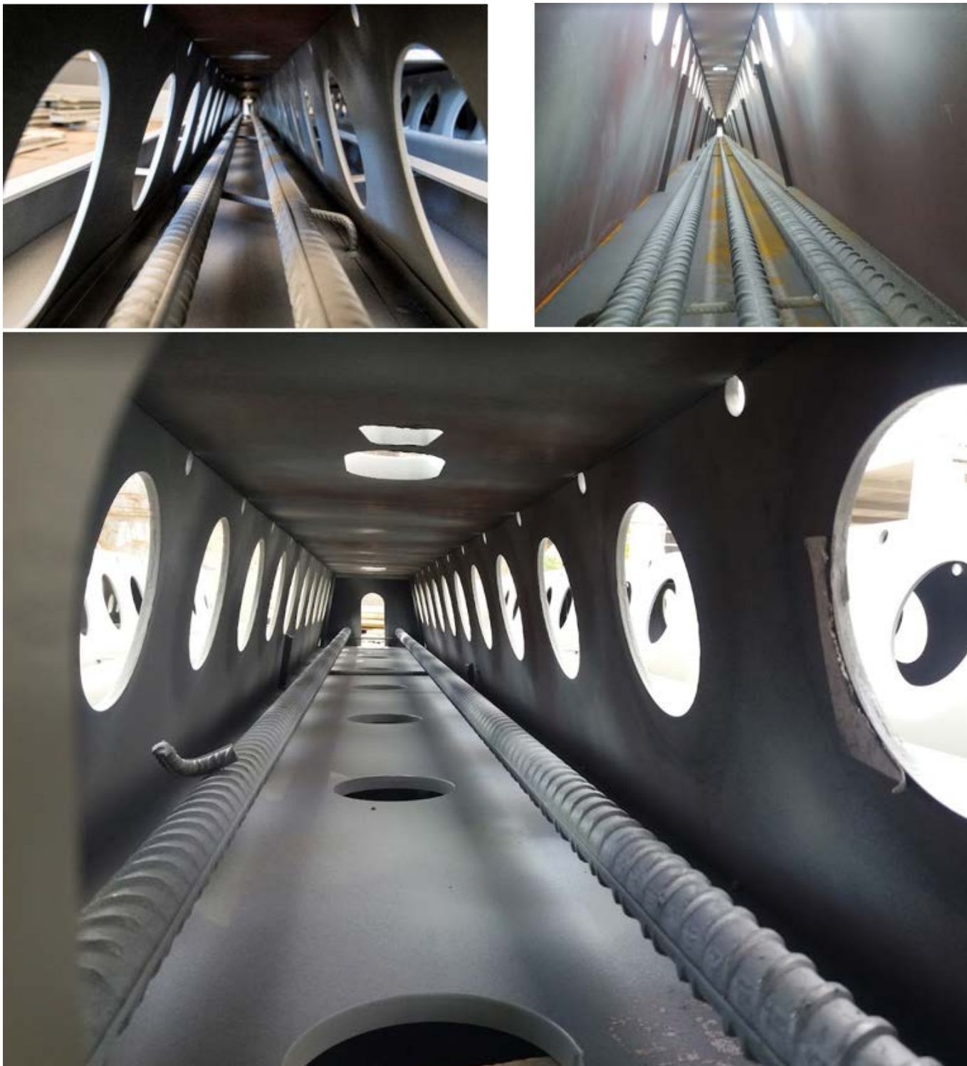
12. ábra: Tűzvédelmi betonacélok a DELTABEAM® belsejében.
