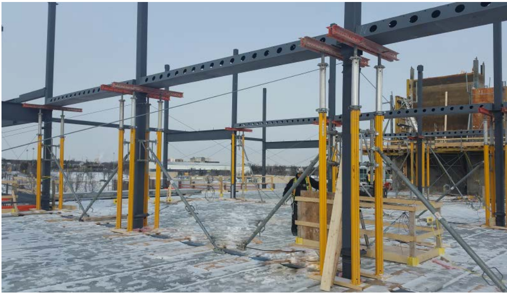
6. ábra: A DELTABEAM® javasolt alátámasztási kialakítás.
