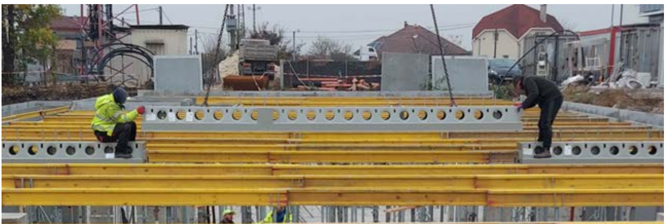
3. ábra: Ábra Gerber kapcsolat a folytonos DELTABEAM® kialakítására.
