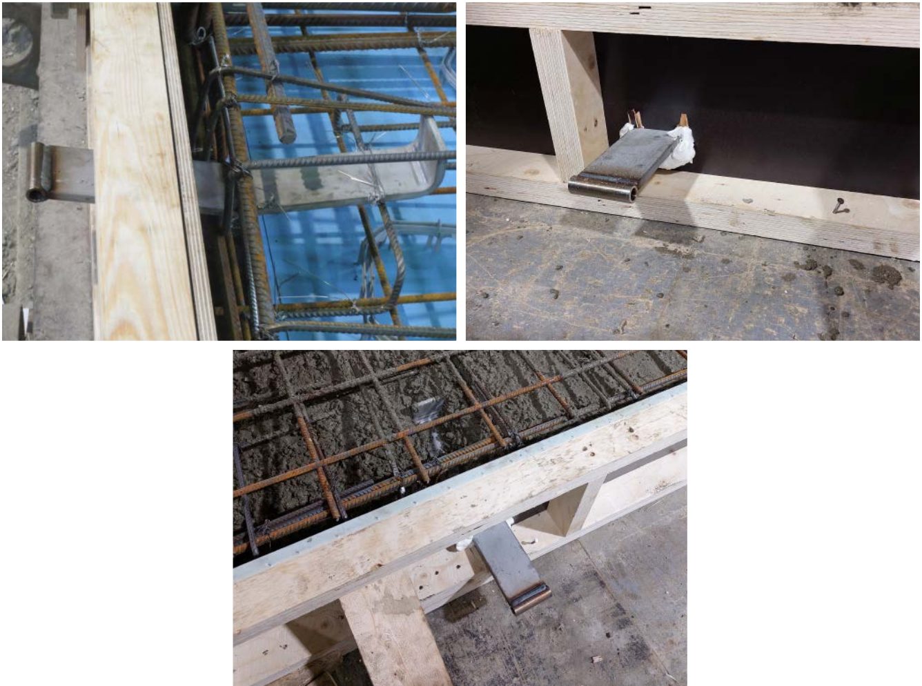
Kuva 12. PS-parvekesaranan Osan B asennus puumuottiin.
