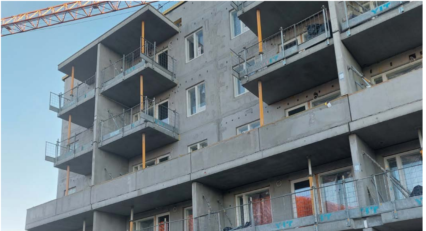
Kuva 1. Liikuntasauamalla jaetut parvekelaatat.
