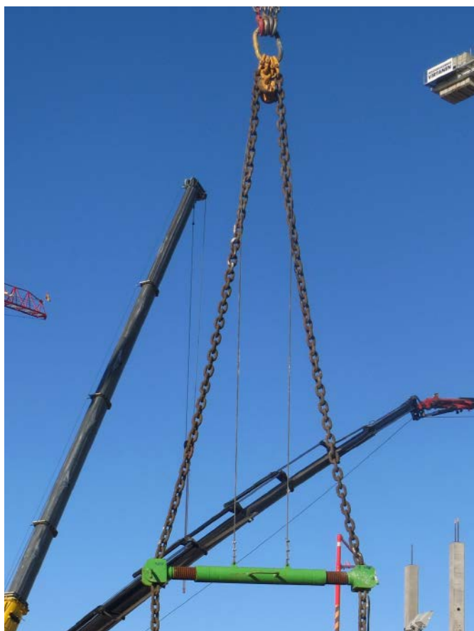
Figura 15. Collegamento del distanziale agli anelli del tirante dell'imbracatura attraverso cavi d'acciaio.
