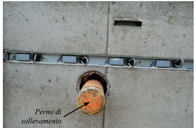
Figura 8. Perno di sollevamento posizionato nel foro.
