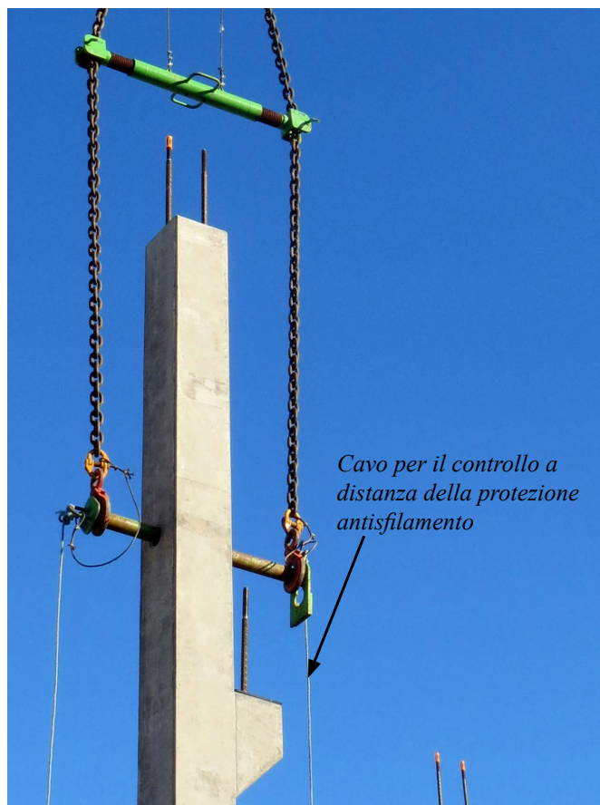
Figura 16. Sistema interamente assemblato incluse le funi per rimuovere la protezione antisfilamento e il perno di sollevamento.
