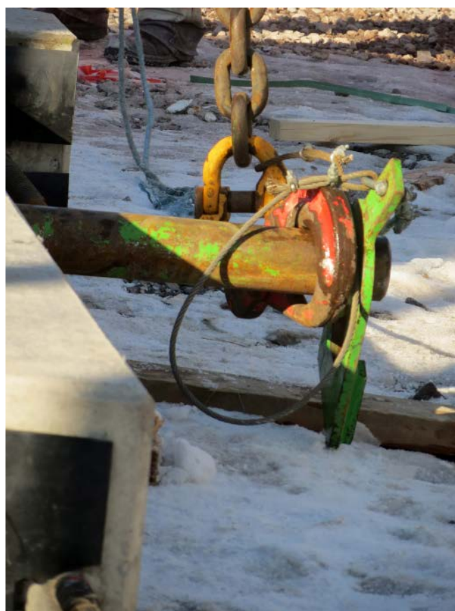
Figura 14. Collegamento della protezione antisfilamento all'imbracatura di sollevamento con un cavo d'acciaio.
