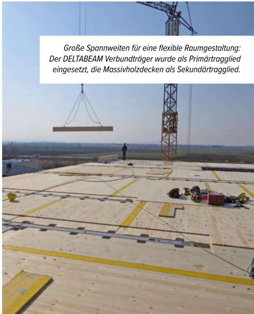
*Große Spannweiten für eine flexible Raumgestaltung: Der DELATABEAM Verbundträger wurde als Primärtragglied eingesetzt, die Massivholzdecken als Sekundärtragglied.*
