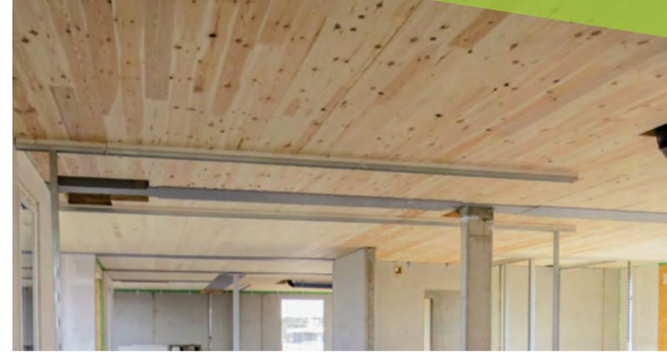
Die Kombination aus Kreuzlagenholz-(KLH-) oder Brettspertholzdecke und Verbundträger mit Aufbeton ergibt eine leistungsfähige Hybrid-Konstruktion.
