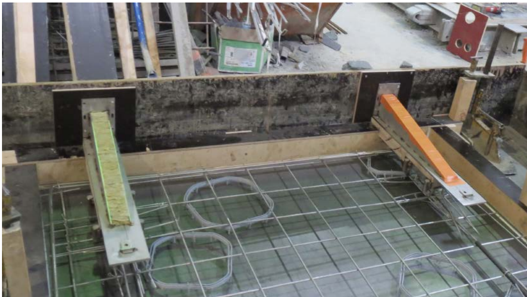
Kuva 21. PIFOREX® kaideosan asennustuen suojaaminen betoniroskeilta.
