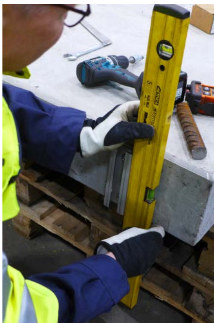
Kuva 27. Esimerkki C-kiskon pystysuoruuden tarkastuksesta vesivaa'alla.
