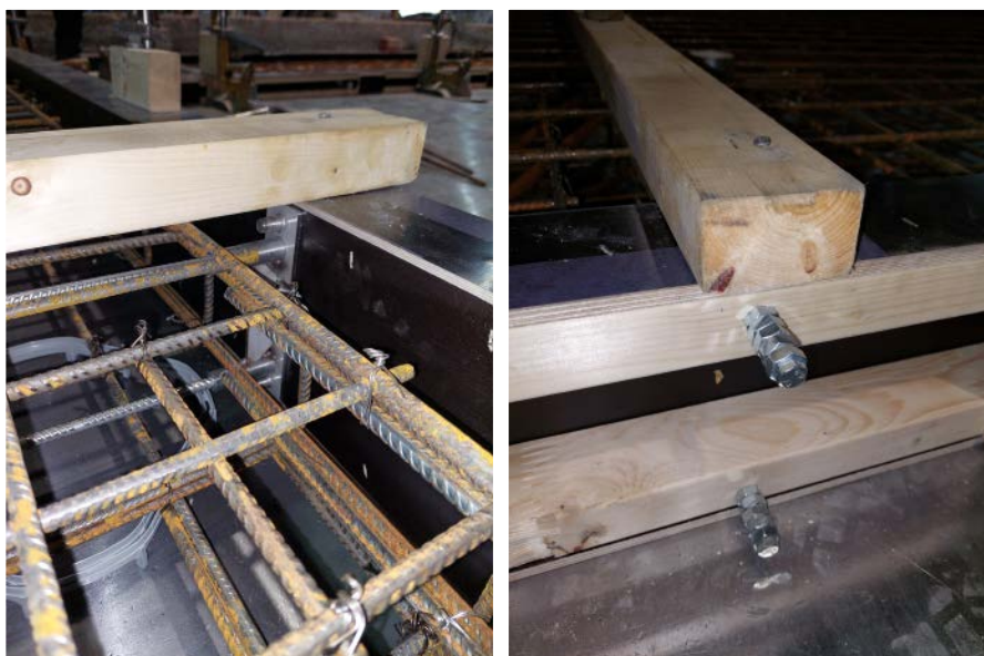
Kuva 14. Laatta-ankkurin kiinnittäminen valumuottiin elementtitehtaalla. Muttereita käytetty aluslevyinä ruuvien pituuden säätämisessä.
