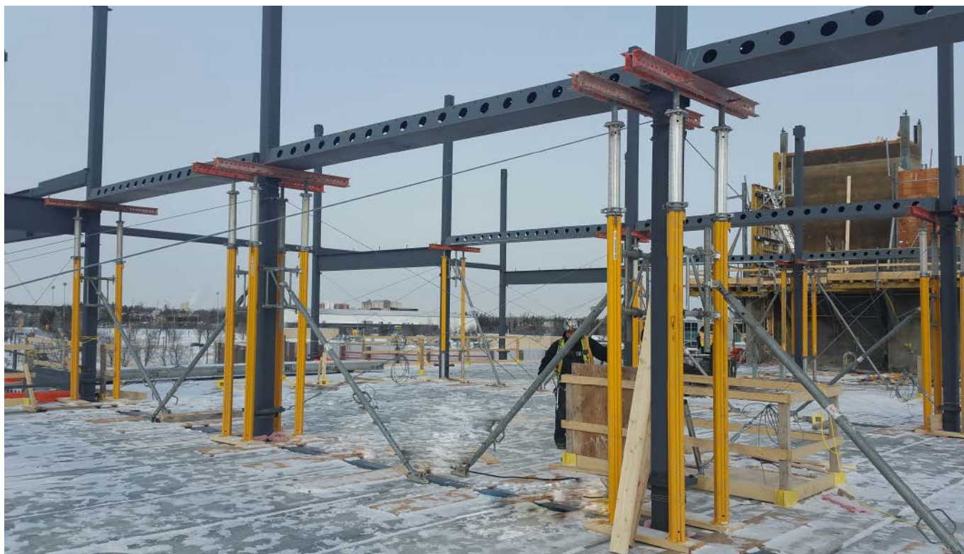
Rysunek 6. Przykładowa metoda stemplowania belek DELTABEAM®.
