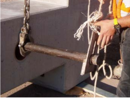
Kuva 22. Nostoraksin kiinnittäminen nostotappiin.
