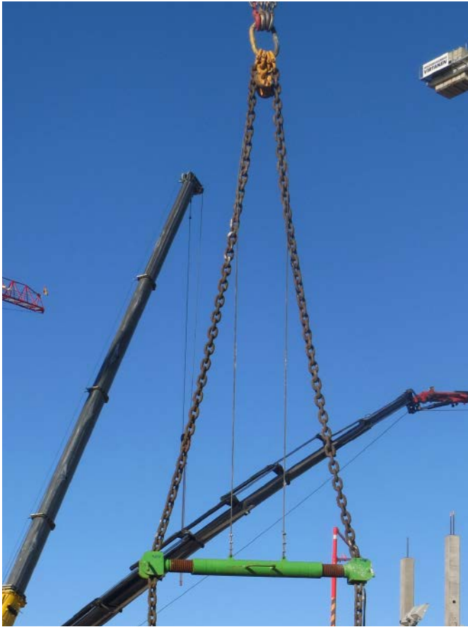
Kuva 15. Nostoraksiohjaimen kiinnittäminen vaijerilla nostorenkaaseen.
