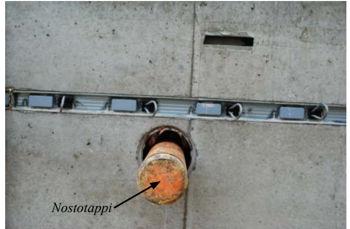
Kuva 8. Nostotappi asennettuna reikään.
