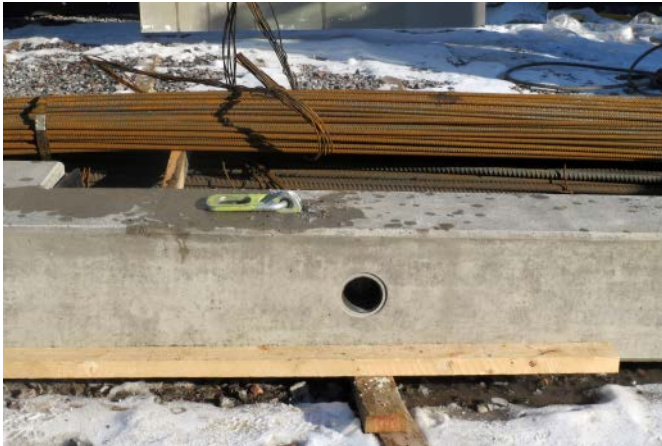
Kuva 7. Nostotapin reikä betonielementissä.
