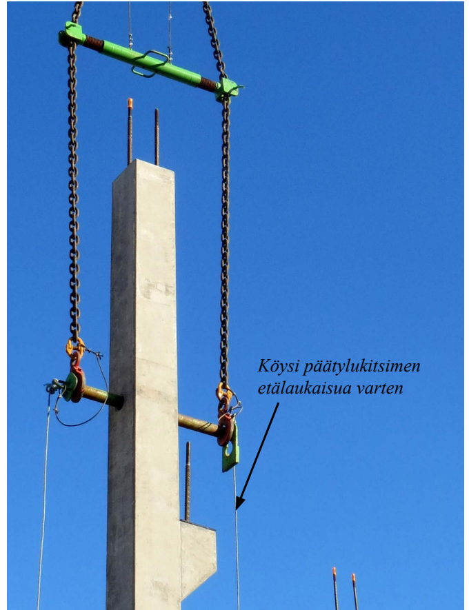
Kuva 16. Järjestelmän osat asennettuna, köydet päätylukitsimen ja nostotapin poistoa varten mukaan lukien.
