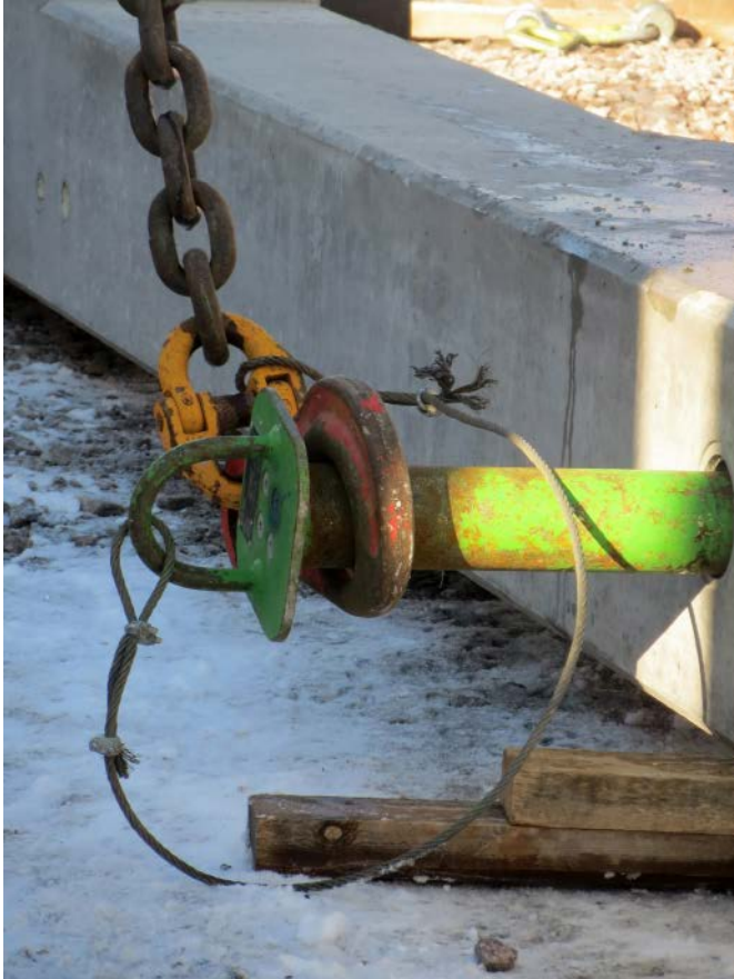
Kuva 13. Nostotappin kiinnittäminen nostoraksiin teräsvaijerin avulla.
