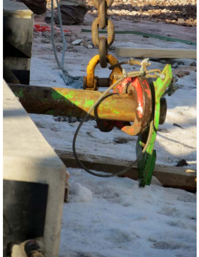
Kuva 14. Päätylukitsimen kiinnittäminen nostoraksiin teräsvaijerin avulla.
