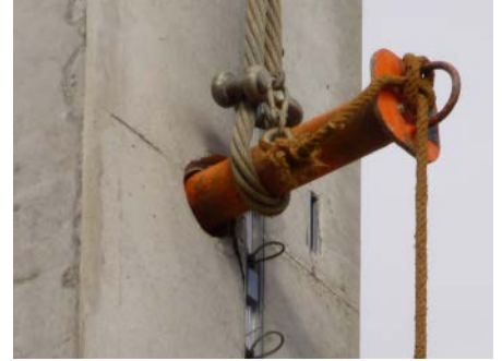
Kuva 24. Nostoraksi kiinnitettynä sakkelin ja vaijerilenkin avulla.
