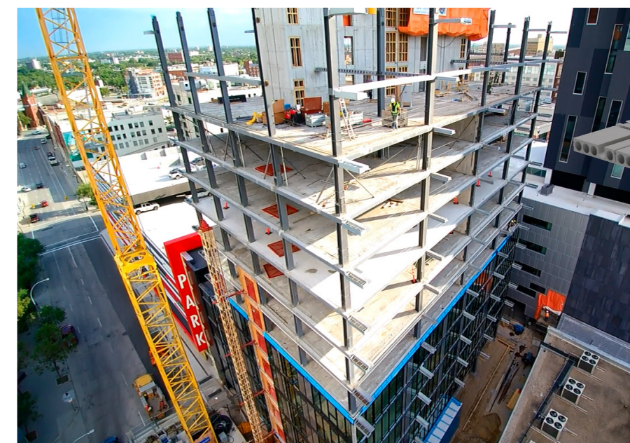
ABBILDUNG 20 ANSICHT DER BAUSTELLE GLASSHOUSE
