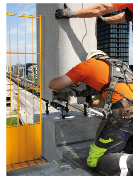
ABBILDUNG 42 AUFSTELLEN EINER FERTIGTEILSTÜTZE AUF DEN VORNIVELLIERTEN MUTTERN UND UNTERLEGSCHIEBEN DER ANKERBOLZEN
