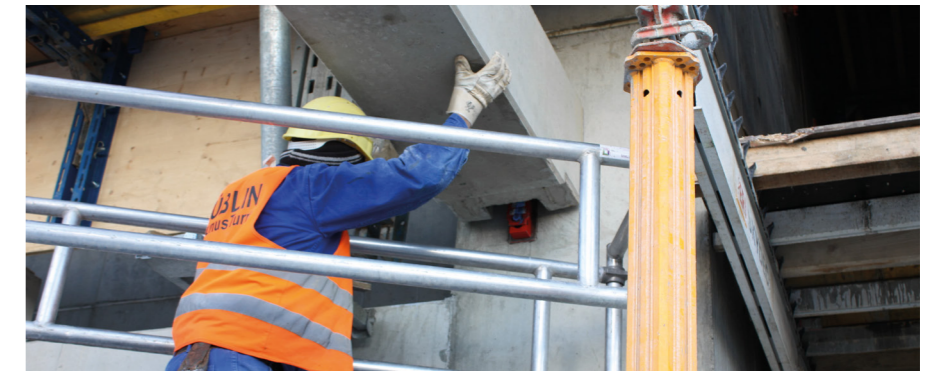
ABBILDUNG 33 MONTAGE DES FERTIGTEIL-UNTERZUGS AUF PCS® KONSOLENPLATTE.
