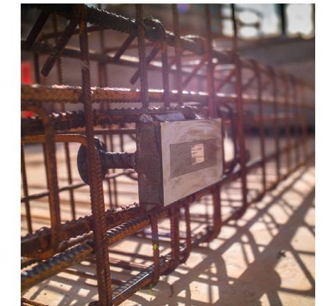
ABBILDUNG 35 IM BEWEHRUNGSKORB DER STÜTZE EINGEBaute PCS® KONSOLE.
