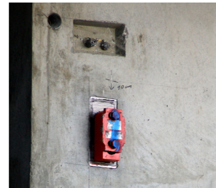
ABBILDUNG 32 DER KONSOLBLOCK DER PCS® KONSOLE WIRD AUF DER BAUSTELLE BEFESTIGT.
