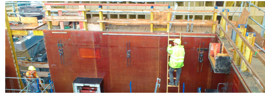
ABBILDUNG 31 PCS® KONSOLEN WERDEN IN DER SCHALUNG DER WÄNDE EINGEBAUT.
