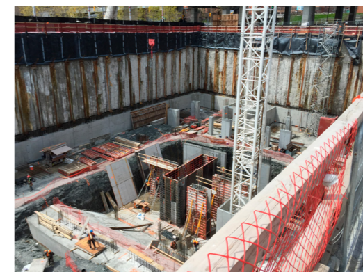
ABBILDUNG 14 DIE GRÜNDUNG DES MONDE MIT ARMATA® QUERKRAFTBEWEHRUNG (LINKS). WANDQUERSCHNITT MIT DURCHSTANZBEWEHRUNG VON PEIKKO (RECHTS).
