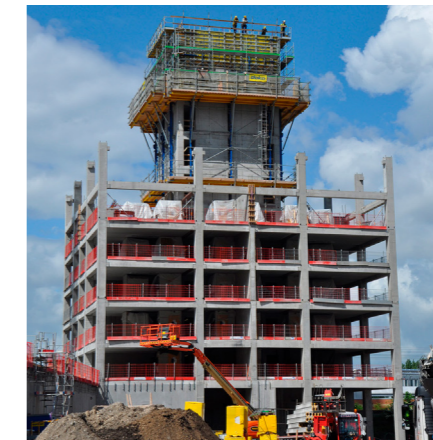
ABBILDUNG 34 ANSICHT DES BAUVORHABENS IN NORDBRO IM BAU
