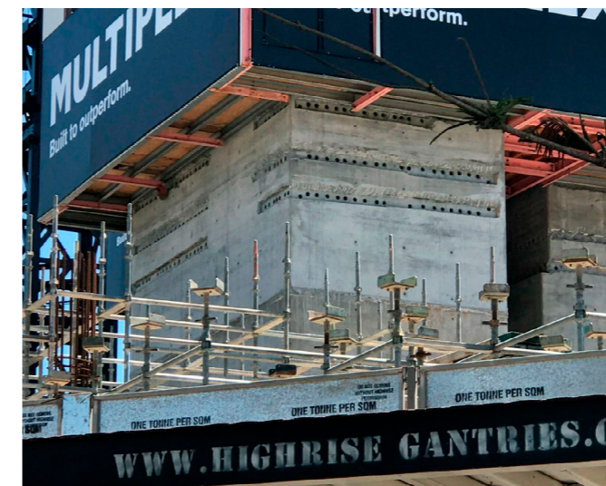
ABBILDUNG 36 ADJUSTA VERBINDUNGEN FÜR DEN ANSCHLUSS DER TRANSFERDECKE, ©MULTIPLY
