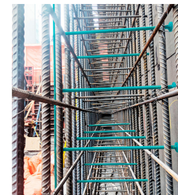
ABBILDUNG 14 DIE GRÜNDUNG DES MONDE MIT ARMATA® QUERKRAFTBEWEHRUNG (LINKS). WANDQUERSCHNITT MIT DURCHSTANZBEWEHRUNG VON PEIKKO (RECHTS).
