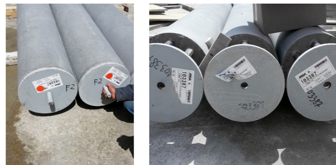
ABBILDUNG 22 BETONFERTIGTEILSTÜTZEN MIT SPEZIAL-ANKERPLATTEN
