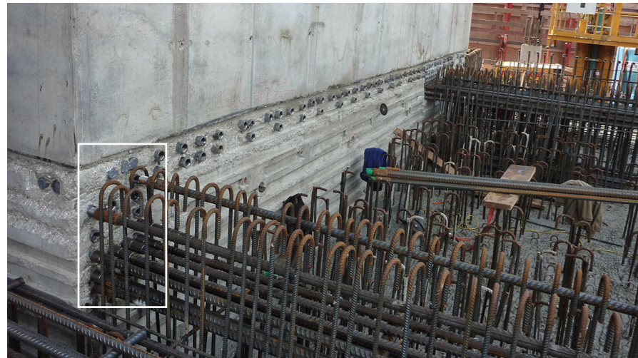
ABBILDUNG 50 DIE BEWEHRUNGSANSCHLÜSSE IM DC TOWER 1 WURDEN MIT MODIX® SCHRAUB-ANSCHLÜSSEN REALISIERT. DIE ABBILDUNG ZEIGT DIE VERBINDUNGEN IM BEREICH DER TREPPENHÄUSER.
