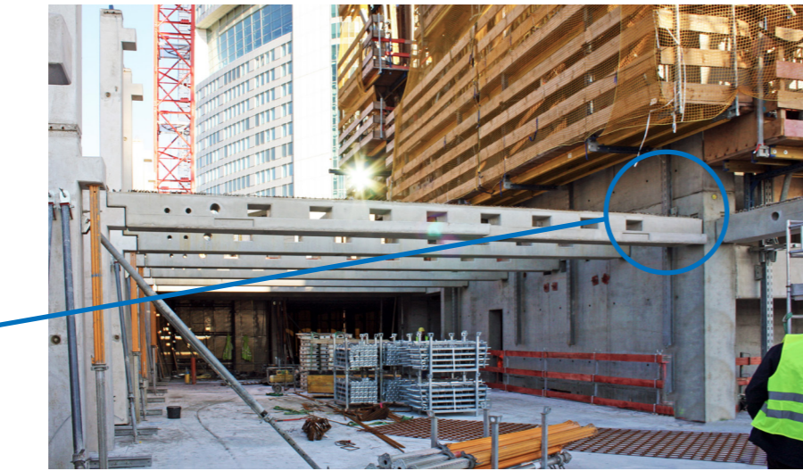
ABBILDUNG 29 BALKENANSCHLUSS AN TRAGENDE WAND MIT PCS® KONSOLE.
