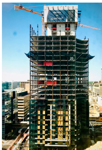
ABBILDUNG 17 DAS 21. GESCHOSS DES 300 MAIN: MONTAGE DER DELTABEAM® VERBUNDTRÄGER UND DECKENELEMENTE.
