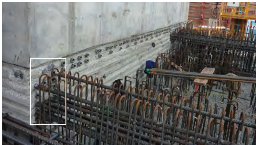
ABBILDUNG 50 DIE BEWEHRUNGSANSCHLÜSSE IM DC TOWER 1 WURDEN MIT MODIX® SCHRAUB-ANSCHLÜSSEN REALISIERT. DIE ABBILDUNG ZEIGT DIE VERBINDUNGEN IM BEREICH DER TREPPENHÄUSER.
