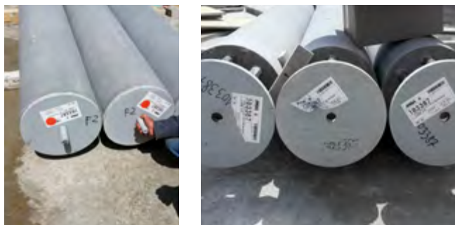
ABBILDUNG 22 BETONFERTIGTEILSTÜTZEN MIT SPEZIAL-ANKERPLATTEN
