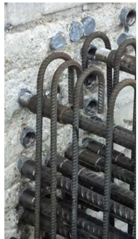
ABBILDUNG 50 DIE BEWEHRUNGSANSCHLÜSSE IM DC TOWER 1 WURDEN MIT MODIX® SCHRAUB-ANSCHLÜSSEN REALISIERT. DIE ABBILDUNG ZEIGT DIE VERBINDUNGEN IM BEREICH DER TREPPENHÄUSER.
