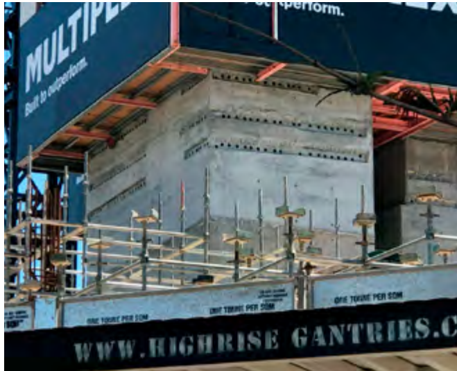
ABBILDUNG 36 ADJUSTA VERBINDUNGEN FÜR DEN ANSCHLUSS DER TRANSFERDECKE, ©MULTIPLEX
