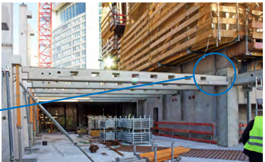
ABBILDUNG 29 BALKENANSCHLUSS AN TRAGENDE WAND MIT PCS® KONSOLE.
