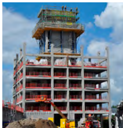
ABBILDUNG 34 ANSICHT DES BAUVORHABENS IN NORDBRO IM BAU
