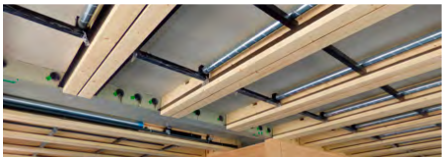
ABBILDUNG 49 UNTERSICHT DER VORGEFERTIGTEN HBV-KONSTRUKTION VOR MONTAGE DER KLIMADECKE
