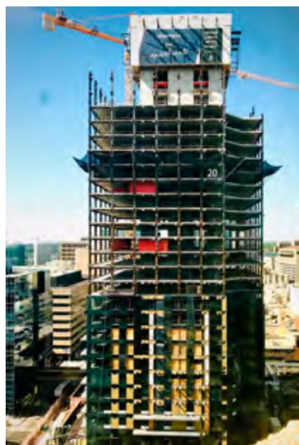
ABBILDUNG 17 DAS 21. GESCHOSS DES 300 MAIN: MONTAGE DER DELATABEAM® VERBUNDTRÄGER UND DECKENELEMENTE.
