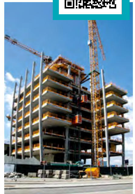
ABBILDUNG 41 COPENHAGEN TOWERS WÄHREND DER BAUPHASE
