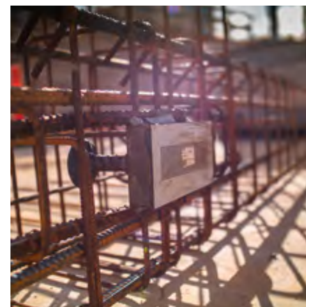
ABBILDUNG 35 IM BEWEHRUNGSKORB DER STÜTZE EINGEBAUTE PCS® KONSOLE.
