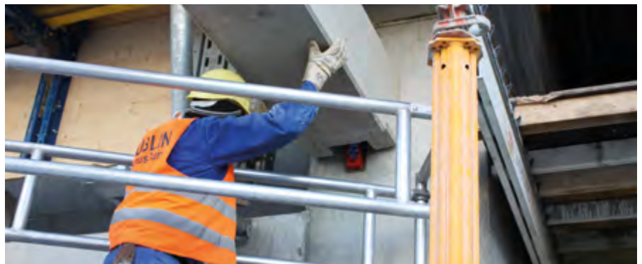
ABBILDUNG 33 MONTAGE DES FERTIGTEIL-UNTERZUGS AUF PCS® KONSOLENPLATTE.
