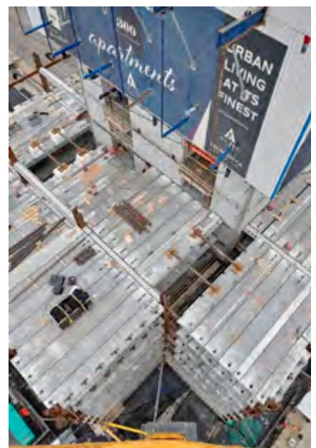
ABBILDUNG 17 DAS 21. GESCHOSS DES 300 MAIN: MONTAGE DER DELATABEAM® VERBUNDTRÄGER UND DECKENELEMENTE.
