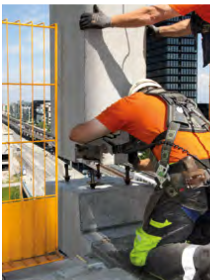
ABBILDUNG 42 AUFSTELLEN EINER FERTIGTEILSTÜTZE AUF DEN VORNIVELLIERTE MÜTTERN UND UNTERLEGSCHIEBEN DER ANKERBOLZEN
