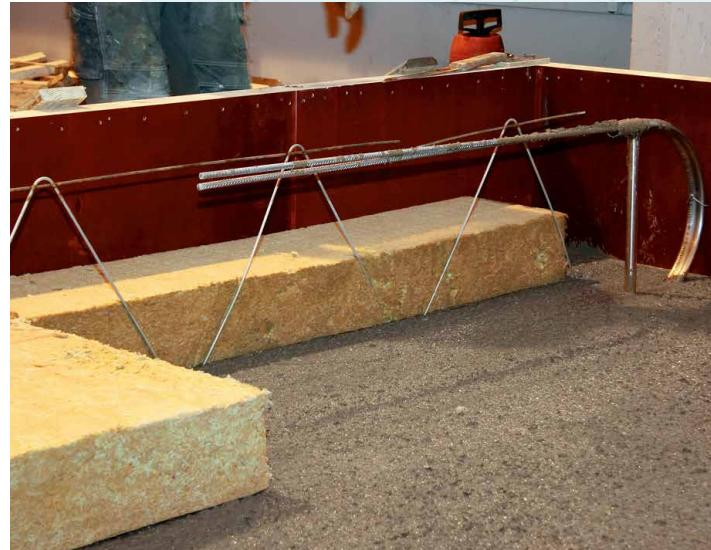
图1. 佩克PD型厚保温墙板连接系统
