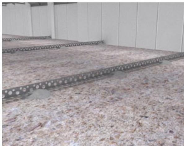
*Ajuster la hauteur de l'UNIRAIL en utilisant, par du personnel qualifié, une lunette laser.*
