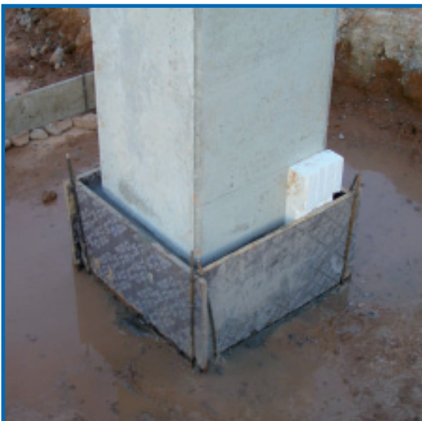
Figura 6. Detalle de encofrado sobre la base del pilar para rellenar la junta.
