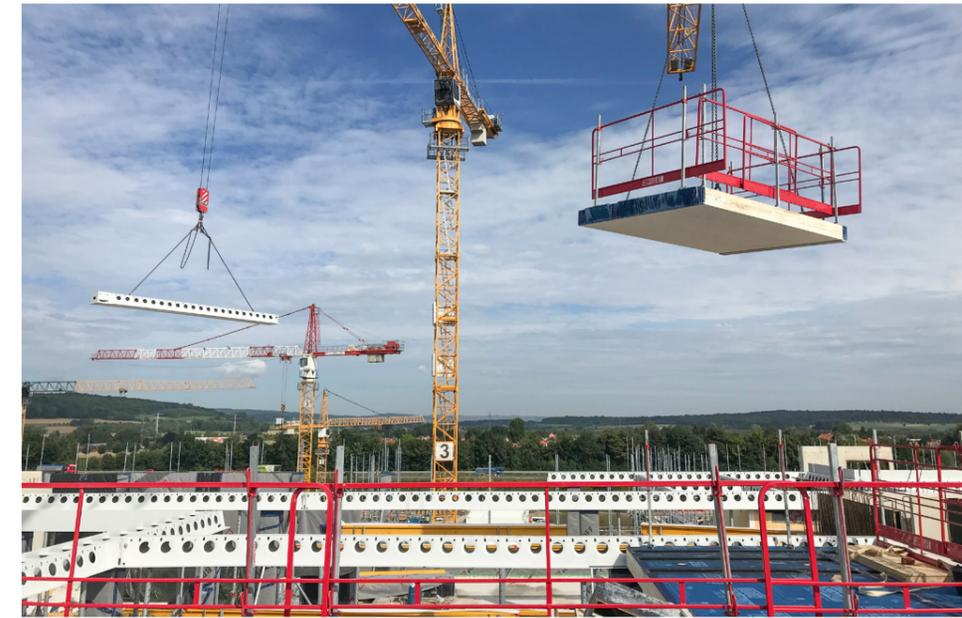
▲ Die DELTABEAM® Verbundträger und die Deckenelemente konnten bereits im Vorfeld im Werk gefertigt werden. Die Montage der Bauteile fand direkt vor Ort in Göttingen statt.
