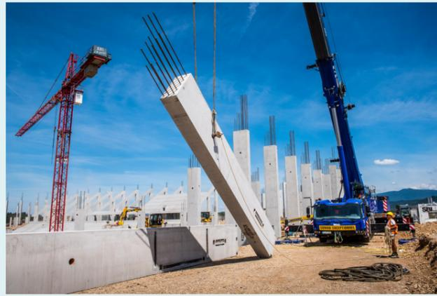
▲ Mit den Stützenverbindungen von Peikko kann man eine Fertigteilstütze innerhalb von 10 Minuten montieren.
