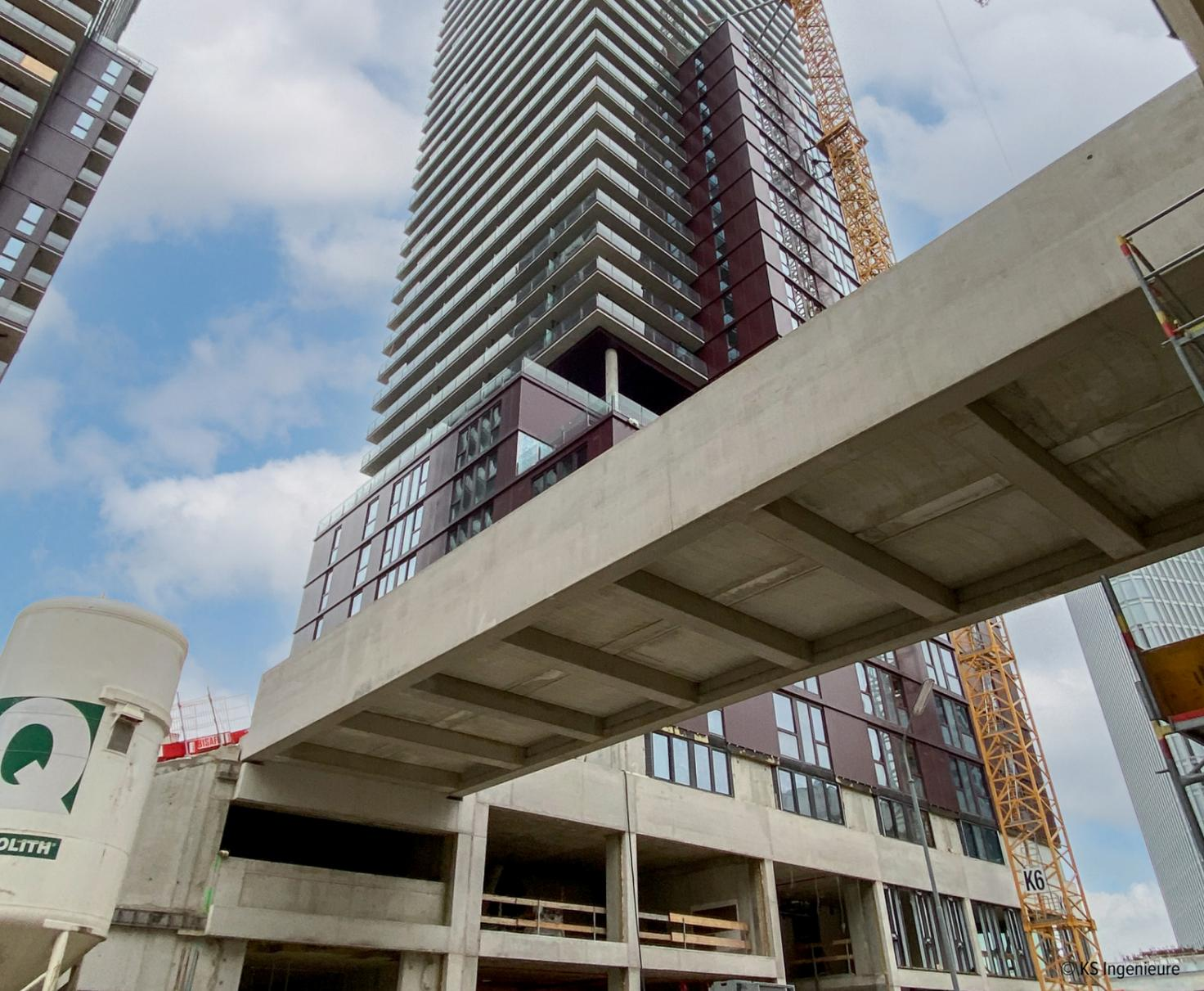
verbundenen Fertigteilträgern. Um eine einfache und schnelle Montage zu ermöglichen, wurden die Haupt- und Nebenträger unter Verwendung von BECO® Balkenschuhen und COPRA® Muffenverbindung von Peikko miteinander verbunden. Auf die Querträger wurde eine
