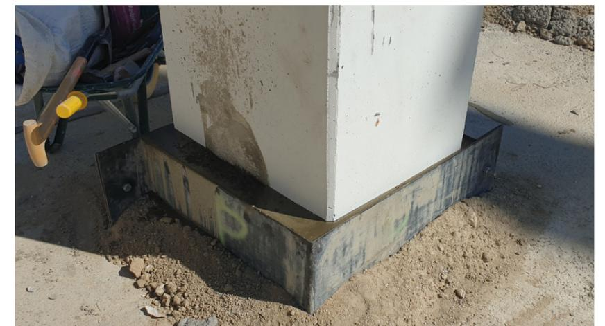
▲ Anschließend werden die Montagefuge und die Aussparungen mit Vergussmörtel verschlossen.
