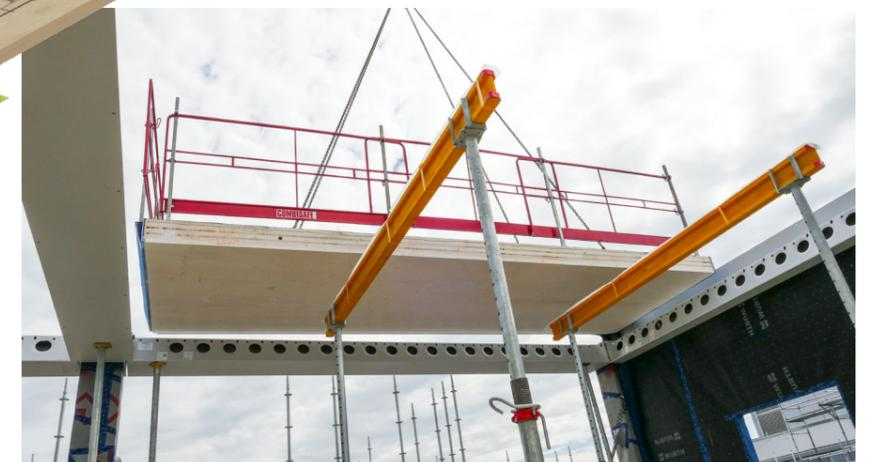
▲ DELTABEAM® von Peikko besteht aus einem trapezförmigen, geschweißten Stahlprofil. Der Untergurt krägt bei den Mittelträgern beidseitig aus und bietet so ein direktes Auflager für das Deckensystem. ▲
