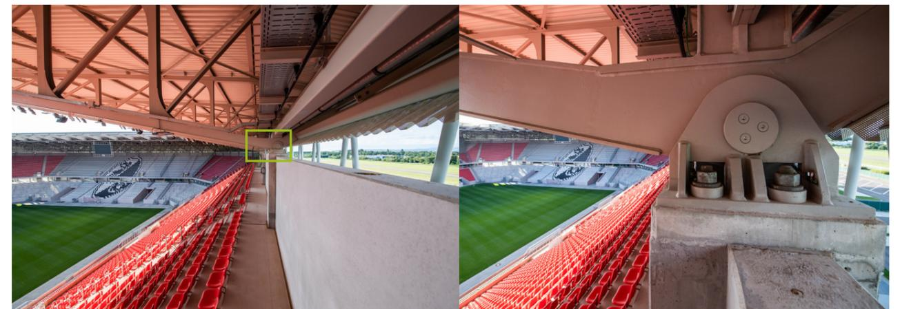
▲ Im Auflager der Dachkonstruktion auf den Betonfertigteilmwänden und -stützen verankern verzinkte Ankerbolzen die Anschlüsse der Stahlbauteile in der Betonkonstruktion.
