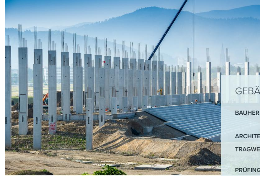
◀ Alle Betonfertigteilstützen dieses anspruchsvollen Bauwerks wurden mit Schraubverbindungen von Peikko an das Fundament angeschlossen.
