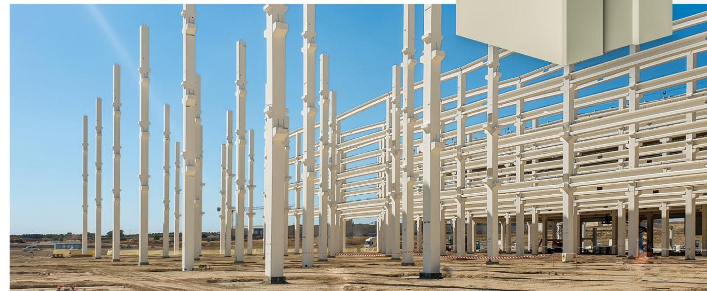
▲ Bei mehr als 400 Stützen mit einer Länge von je 22 Metern war der Einsatz von Schraubverbindungen eine logische Wahl.
