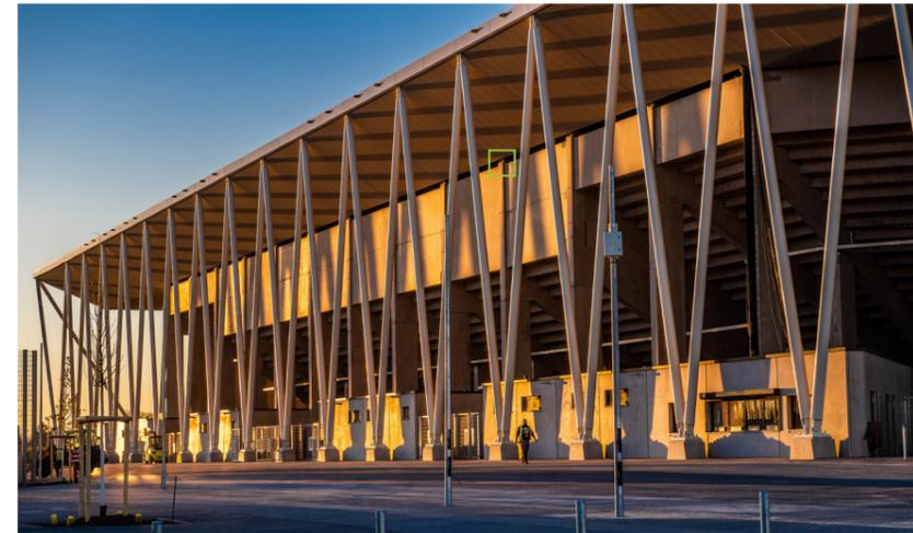
▲ Die Fachwerkträger des Daches werden von außenliegenden, geneigten Stahlstützen gehalten, die die Zugkräfte in die Fundamente einleiten.
