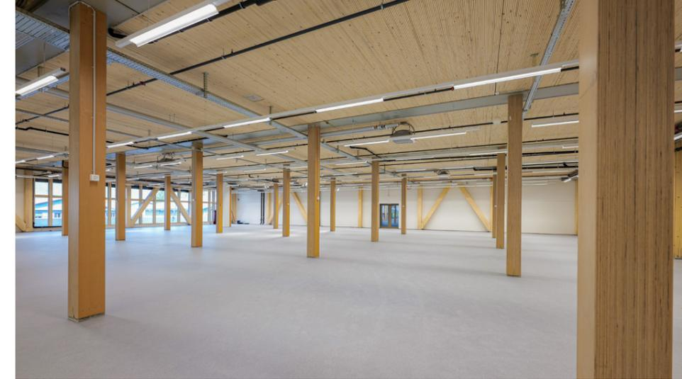
▲ Blick ins Innere des neuen LANDI-Verkaufsladens. Im Hintergrund gut sichtbar die diagonalen, massiven K-Verbände aus Schwyzer Fichtenholz.
