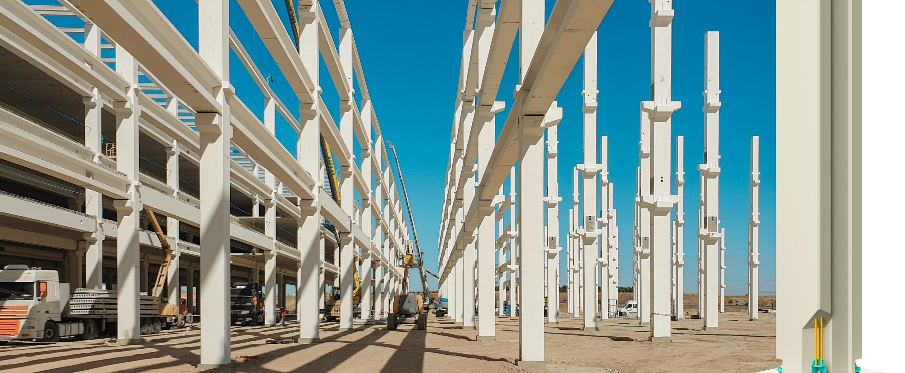
▲ Arbeitsräume bleiben während der Bauphase frei, da die Stützen nach der Montage keinerlei Abspreizungen benötigen.
