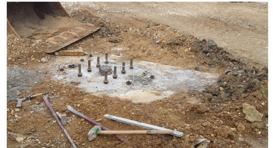
▲ Die Ankerbolzen können mit einer Einbauschablone als Zubehör präzise im Fundament positioniert werden.
