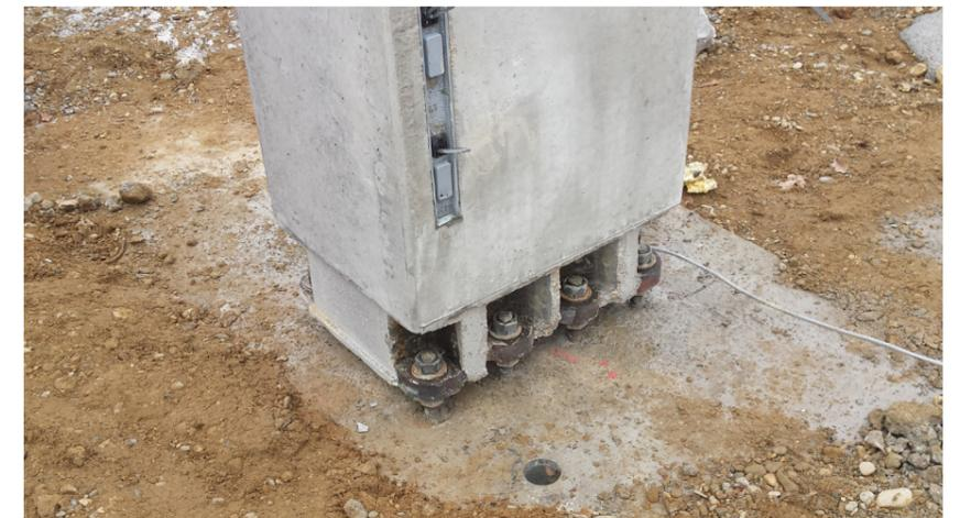
▲ Die Betonfertigteilstütze wird über die Ankerbolzen geführt, auf Futterbleche oder direkt auf die unteren Muttern und Unterlegscheiben abgesetzt, ausgerichtet und mit den Ankerbolzen kraftschlüssig verschraubt.
