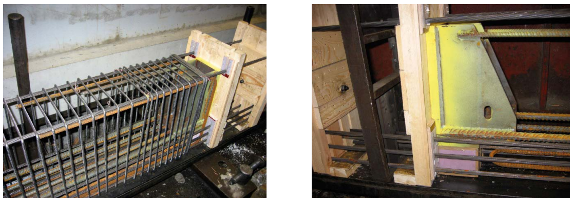
Figura 12. Ejemplo de armadura de refuerzo adicional y colocación del Pie Viga PC® antes del hormigonado.
