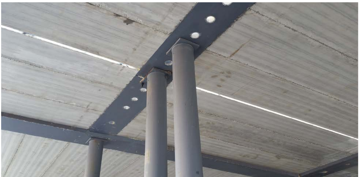
Figur 24. Fabriksinstallerad hylsa för rörgenomföringar.
